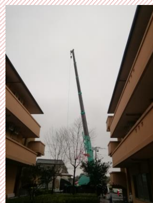
大規模修繕で クレーン車登場!!
